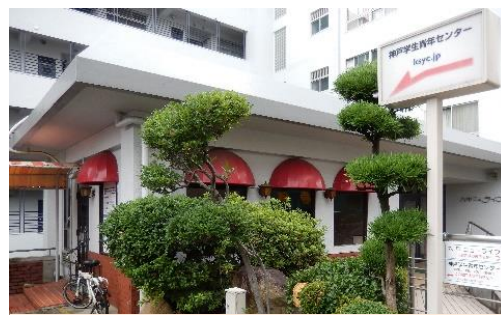
【神戸学生青年センターサロン室外観】
